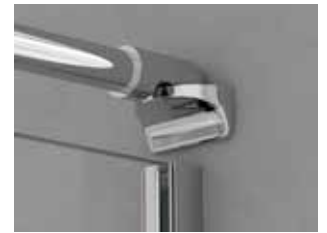
Detalle terminal pared barra de sujeción
